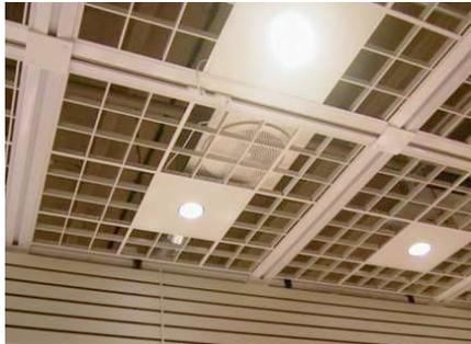
写真11と12は、パンチングメタルでなく、多くの小孔を持つ吹き出し口であり、このタイプはIEA (国際エネルギー機構) Annex20「数値手法による室内気流・空気汚染の評価」の研究においても複雑気流を形成する典型例として多く検討され、研究者の間では「IEA ディフューザ」と呼ばれている。
