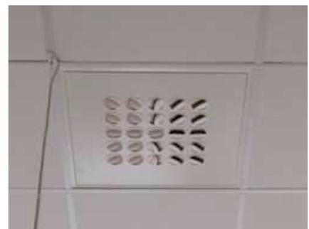
北欧ではまだ見かけていないが、写真 13 に示すドイツ・フランクフルト空港の例のように、ライン状で多数の小孔があるタイプは、ヨーロッパでは良くあると聞く。なお、右写真は、天井埋め込み式ではなく、間接照明がされている天井面近くに中写真の様な多数の小孔を持つライン状の水平吹き出しチャンバーが設置されている。
